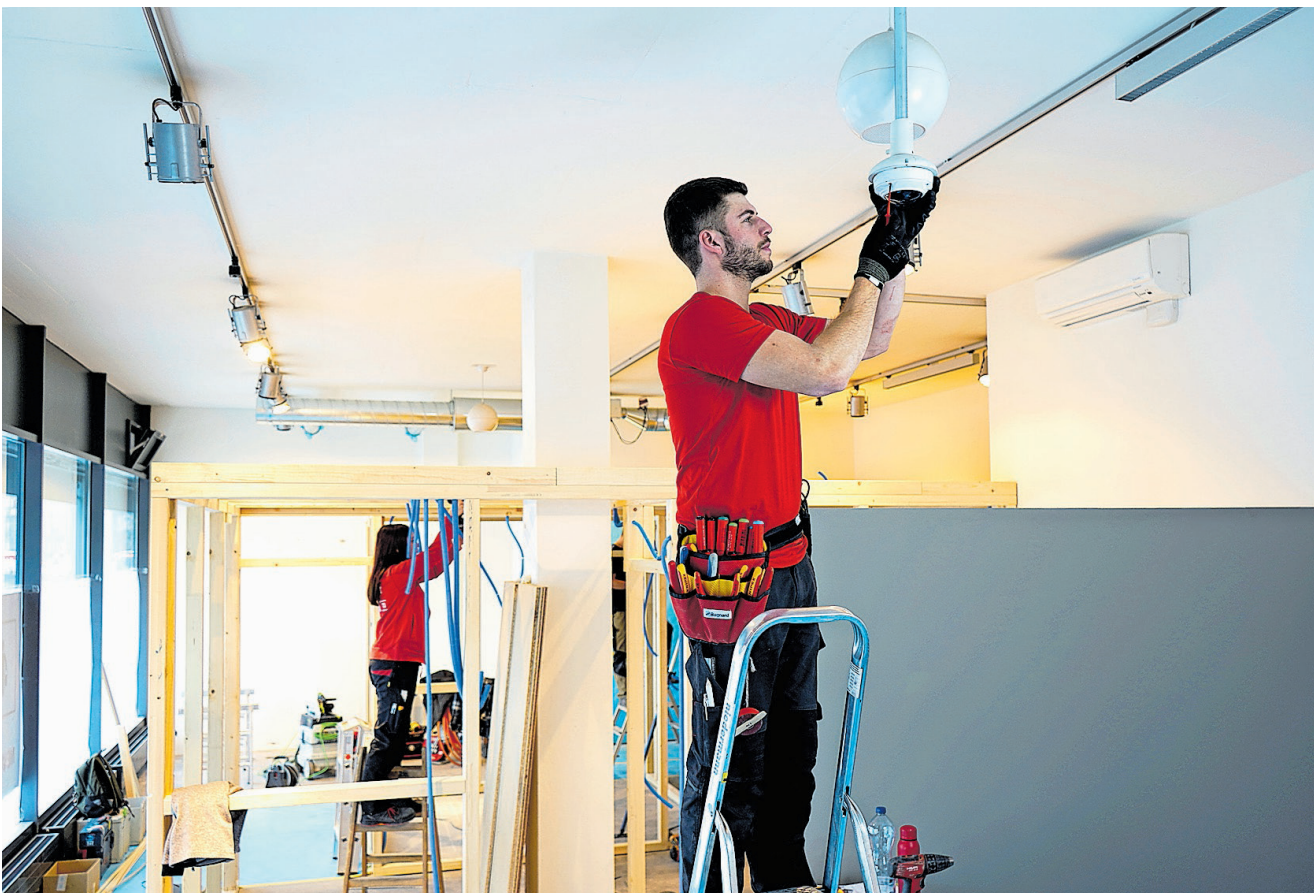
Elektroinstallateur Jonas Durrer und Lehrling Lynn Sonder arbeiten am Umbau einer Ausstellung.
